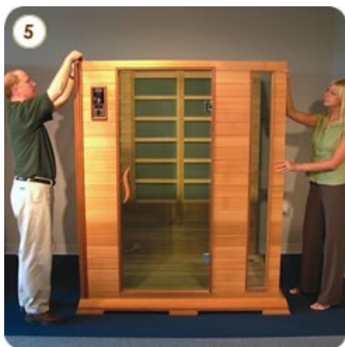
Instalacja przedniej ścianki
