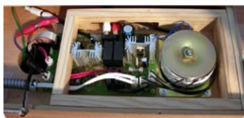
Instalacja promienników podczerwieni
